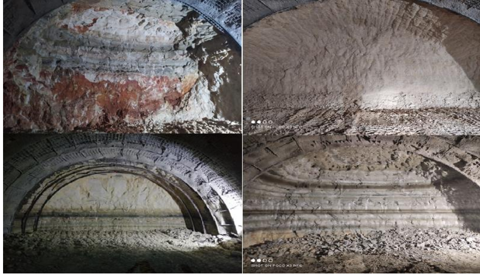
Şekil 5. Tünel güzergâhında bulunan birimlerin tünel içerisindeki görünümü
