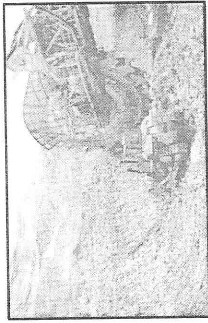
Şekil 3. Ortu tabakası içinde düzensiz olarak görülen sert malzemelerin yardımcı makinalar ile kazılması.
