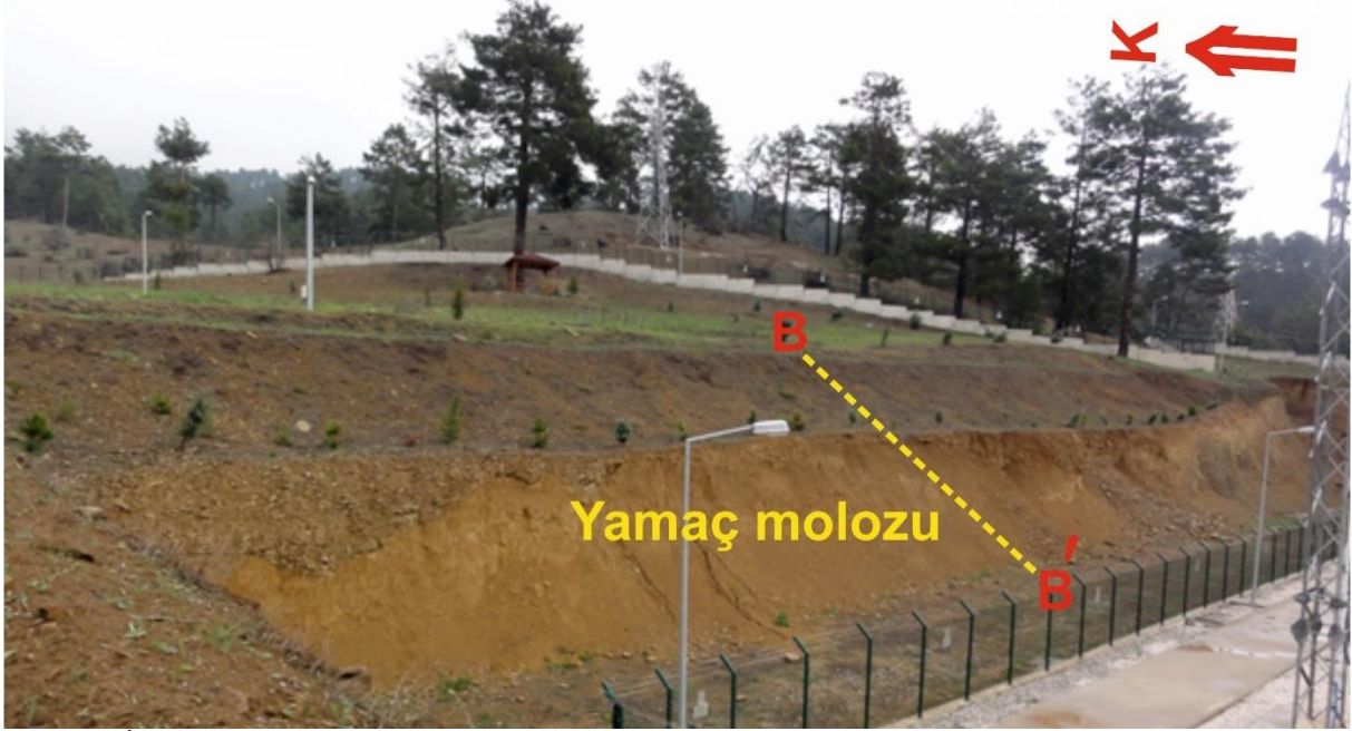
Şekil 3. İnceleme alanında şev duraylılık analizi için seçilen B-B' kesit hattı
