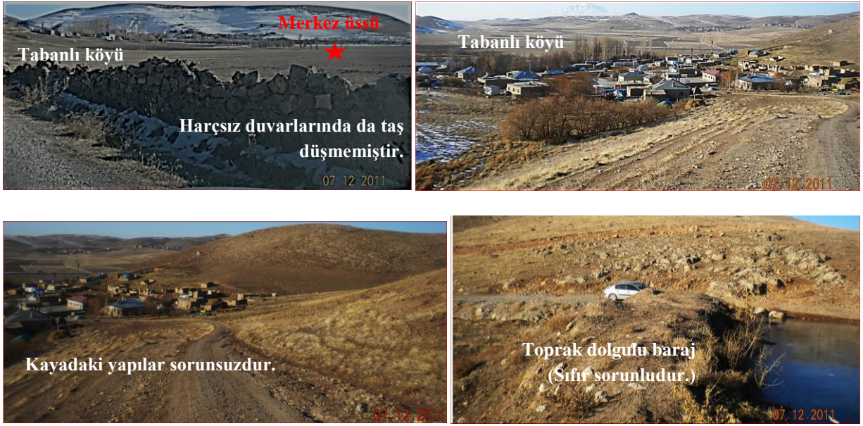
Şekil 4. Ovanın çamurundan kurtulmak için evlerini yamaç eteği ve yamaca kuran Tabanlı köylüleri depremi can kaybı ve yaralanma olmadan atlarken harçsız taş duvarları (a,b,c) ve toprak dolgu barajları da (d) sorunsuzdur. Figure 4. The villagers of Tabanlı, who built their houses on the slopes to get rid of the mud of the plain, survived the earthquake without loss of life or injury, while the stone walls (a,b,c) and earthfill dams without mortar (d) are also without problems.
